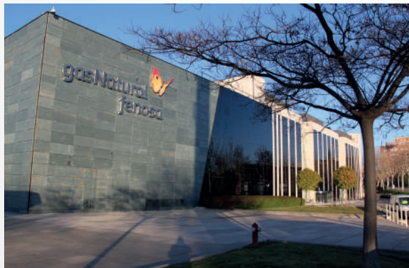
Edif. Thyssen (Madrid).
